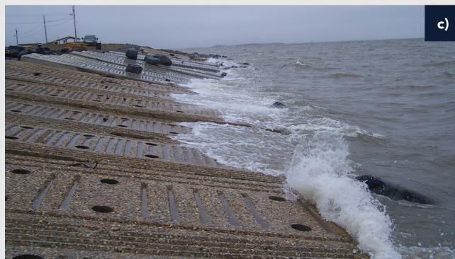
FIGURE 23 : Divers types de mesures de protection du littoral : a) sacs de sable mis en place en 1987, b) rochers (perré) utilisés pour la première fois en 1997, et c) dalles de béton monolithiques installées en 1998. Photos a) et b) gracieusetés de S. Solomon, et photo c) gracieuseté de G. Manson.
