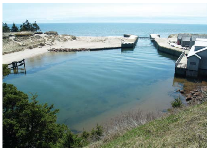
FIGURE 16 : Mesures hybrides de protection à Basin Head, à l'Île-du-Prince-Édouard; revêtement enseveli recouvert de dunes et d'ammophile à ligule courte. Photo gracieuseté de M. Davies.
