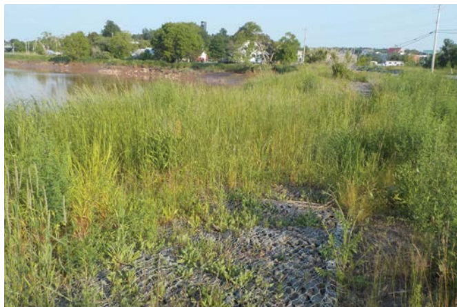
FIGURE 24 : Côte hybride vivante sur la rivière Shubenacadie, dans la baie de Fundy, en Nouvelle-Écosse, illustrant des gabions replantés de végétation des marais dans le but de réduire l'affouillement par érosion. Photo gracieuseté de V. Leys, août 2015.
