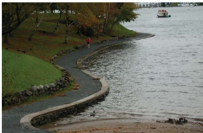
FIGURE 14 : Mesures structurelles sur le littoral en Nouvelle-Écosse. Photo gracieuseté de M. Davies.
