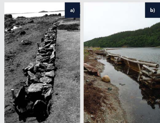
FIGURE 16 : Deux méthodes de construction différentes utilisées en vue de protéger des sites archéologiques dans la baie de Bonavista, T.-N.-L. : a) le mur de gabions construit à l'île Inspector (Pastore, 1987) a réussi à protéger le site pendant trois décennies; b) les digues à la mer en bois ont toutes cédé sur le site Beaches. Photo b) gracieuseté d'Anita Johnson-Henke.
