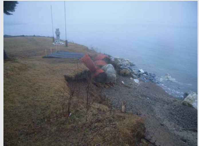
FIGURE 15 : Cimetière de Malagawatch, N.-É., où des restes humains enterrés ont été entraînés par l'érosion dans la mer à la suite de plusieurs tempêtes. La protection initiale du site faisait appel à un perré (comme on peut le voir en contrebas de la croix). Les tempêtes et l'érosion subséquentes ont mené à la protection temporaire des sépultures par des balles de foin ancrées et une membrane perméable (centre de la photographie). La planification de mesures de protection plus permanentes est en cours. Photo gracieuseté de Heather MacLeod-Leslie.
