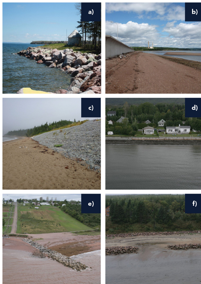
FIGURE 22 : Structures de protection côtière communément utilisées dans la région de la côte Est (tiré de Jennings et al., 2008) : a) enrochement bordant les lieux de sépulture ancestraux de Malagawatch, au sud-ouest du lac Bras d'Or, N.-É. (S. O'Carroll, Geo Littoral Consultants); b) ouvrage longitudinal, à la Première Nation d'Eel River Bar, au nord-est du Nouveau-Brunswick (D. Bérubé, Ministère de l'Énergie et des Mines du Nouveau-Brunswick); c) revêtement, à Mispec, au sud-ouest du Nouveau-Brunswick (D. Bérubé, Ministère de l'Énergie et des Mines du Nouveau-Brunswick); d) mur de rétention, à Maria, en Gaspésie, au Québec (Laboratoire de dynamique et de gestion intégrée des zones côtières de l'Université du Québec à Rimouski); e) épi, à Paspédiac, en Gaspésie, au Québec (Laboratoire de dynamique et de gestion intégrée des zones côtières de l'Université du Québec à Rimouski); f) digue à la mer, à la pointe Lebel, sur la côte nord de l'estuaire du Saint-Laurent, au Québec (Laboratoire de dynamique et de gestion intégrée des zones côtières de l'Université du Québec à Rimouski).
