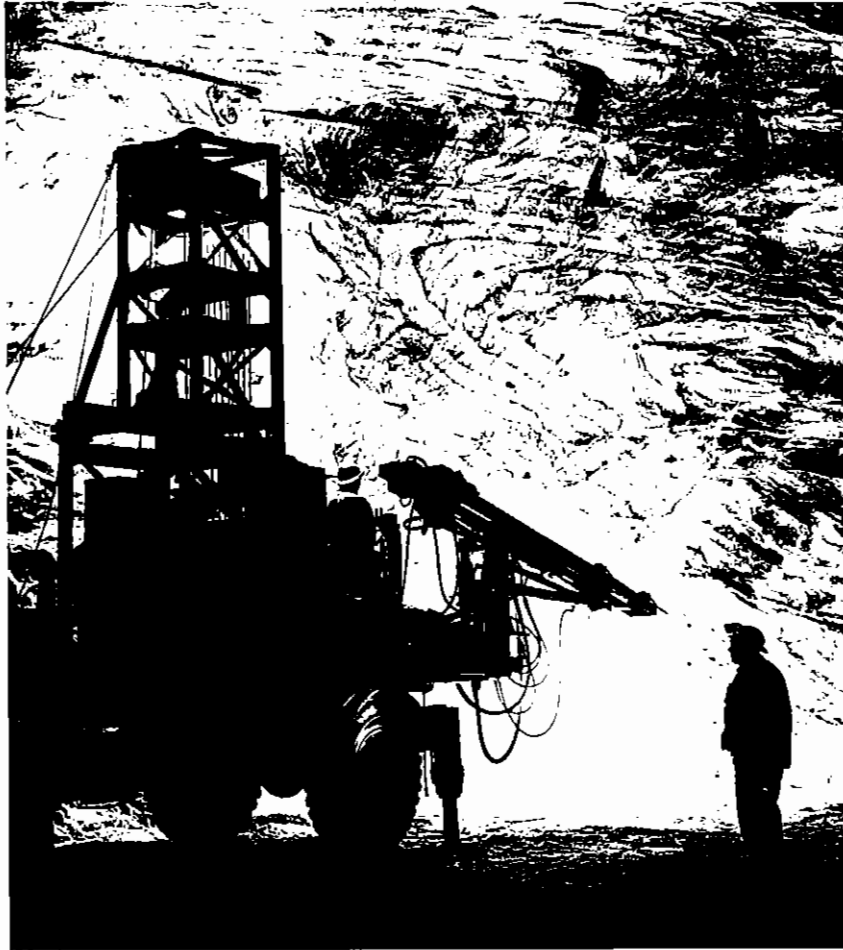
Des foreuses à manchon de refroidissement servent à forer le front de taille.
