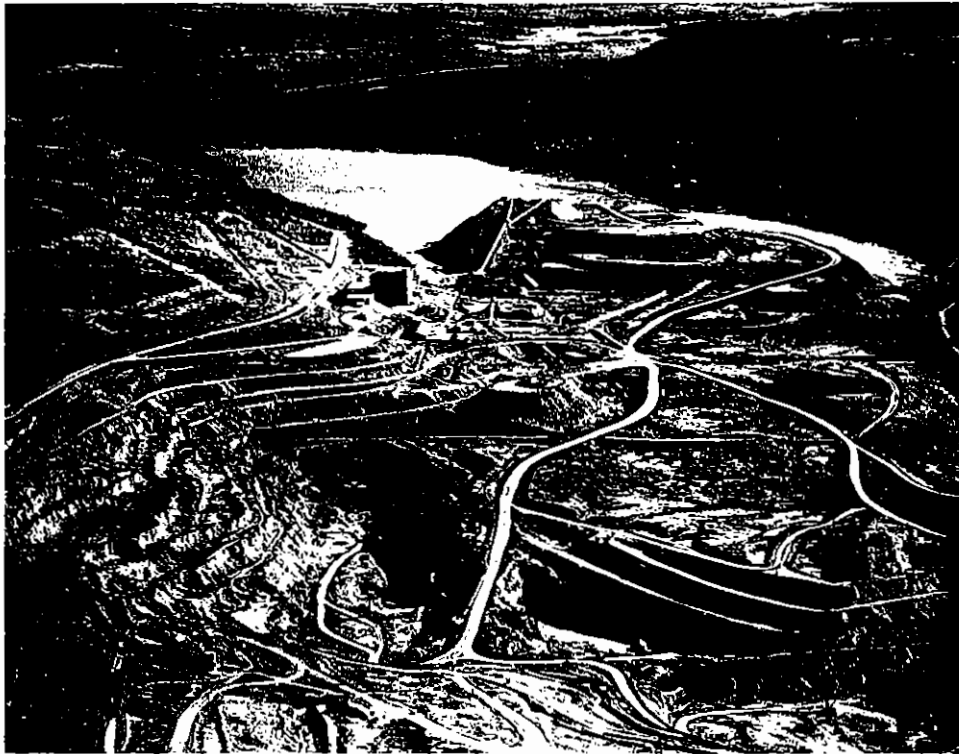
La mine à ciel ouvert et l'atelier de la Lake Asbestos of Quebec Ltd. à Black Lake (cantons de l'Est du Québec). Pour mettre à nu le gîte, qui était recouvert par le lac Noir, il a fallu effectuer de nombreux travaux de dragage et d'irrigation. On voit à l'arrière-plan ce qui reste du lac. Les cantons de l'Est fournissent la majorité de l'amiante canadien et 40 p. 100 de la production mondiale.
