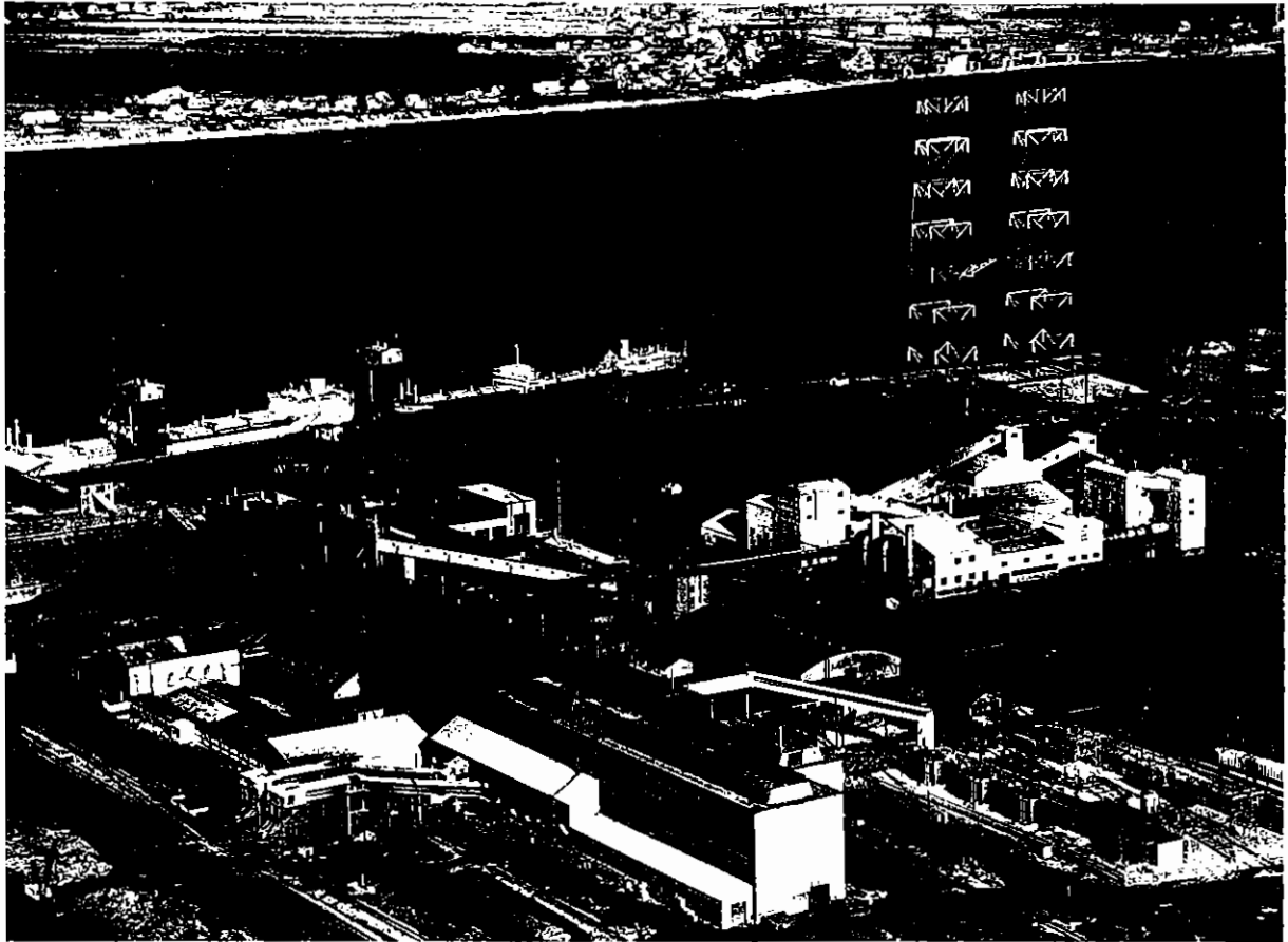
Vue de l'atelier de la Quebec Iron and Titanium Corporation à Ville-de-Tracy (Québec) sur le St-Laurent. L'ilménite entassée sur les quais est d'abord traitée dans l'atelier de concentration (à droite), et puis dans l'atelier de pyrométallurgie (à gauche). Les produits ouvrés (fonte et scories riches en oxyde de titane) sont chargés dans des wagons que l'on voit à l'avant-plan à gauche.
