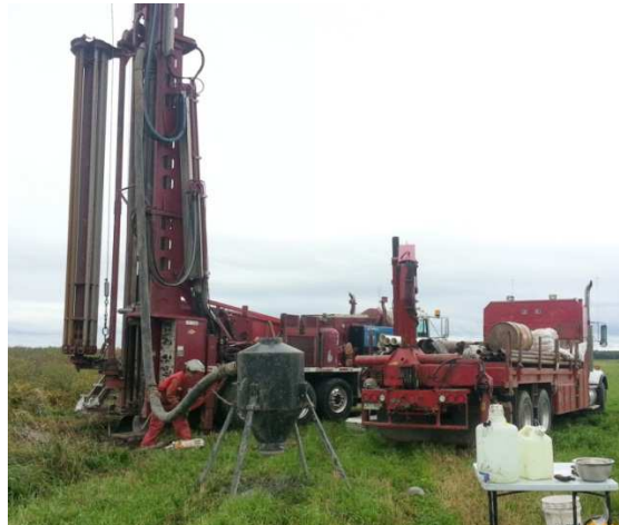
Figure 7. Forage des puits par la méthode destructive (puits F5)
