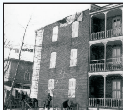
Immeuble à logements
