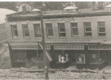
Dommages à la Banque de Montréal, causés par un séisme à Port Alberni (C.-B.), en 1946.
