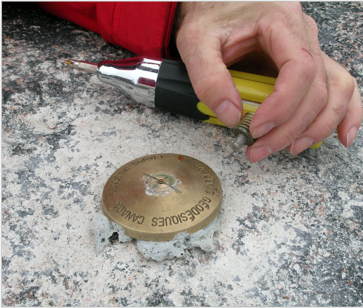
Installation du médaillon.
