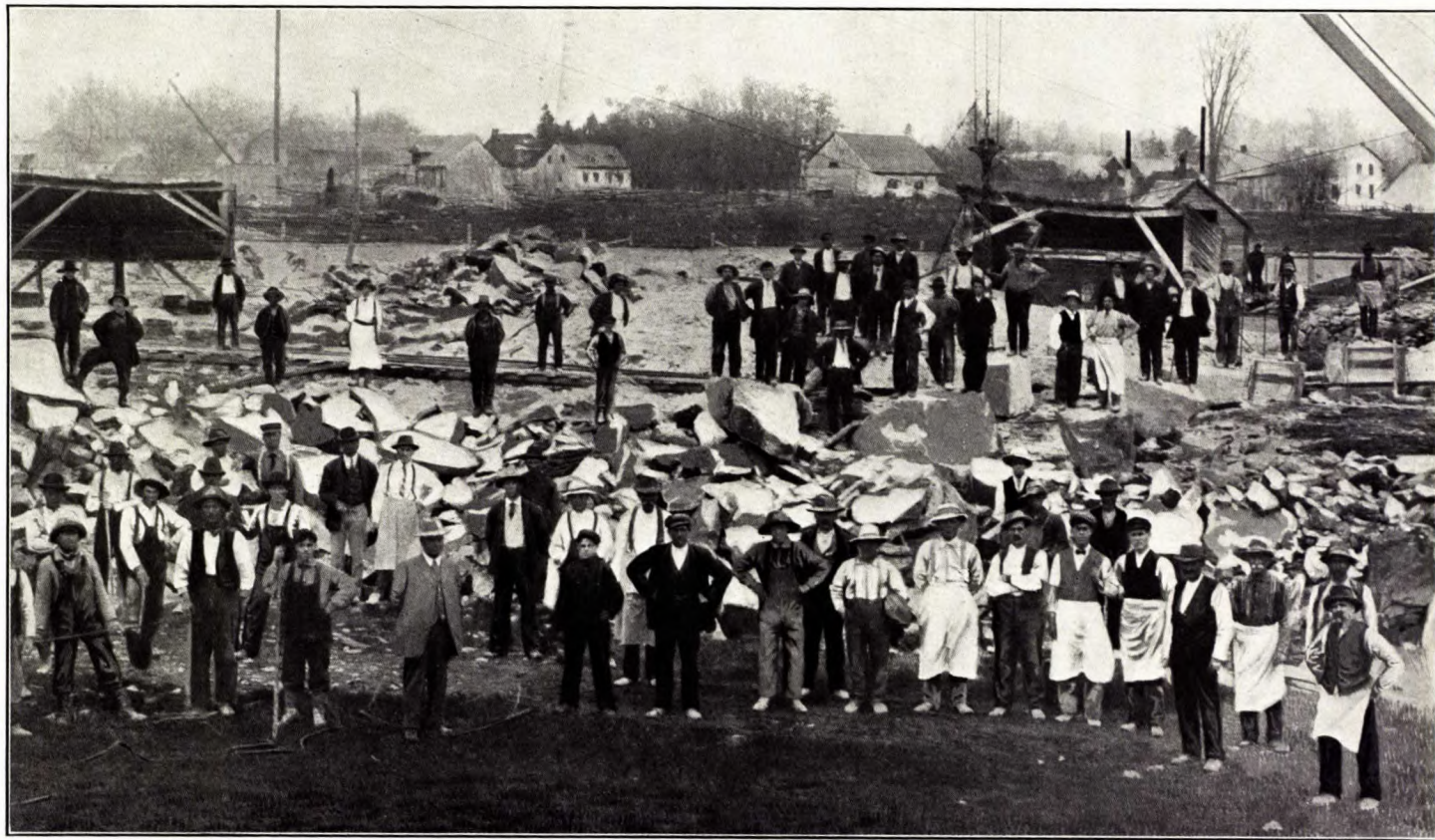
St. Marc des Carrières limestone. Quarry of Georges Chateauvert et Cie., St. Marc des Carrières, Que.
