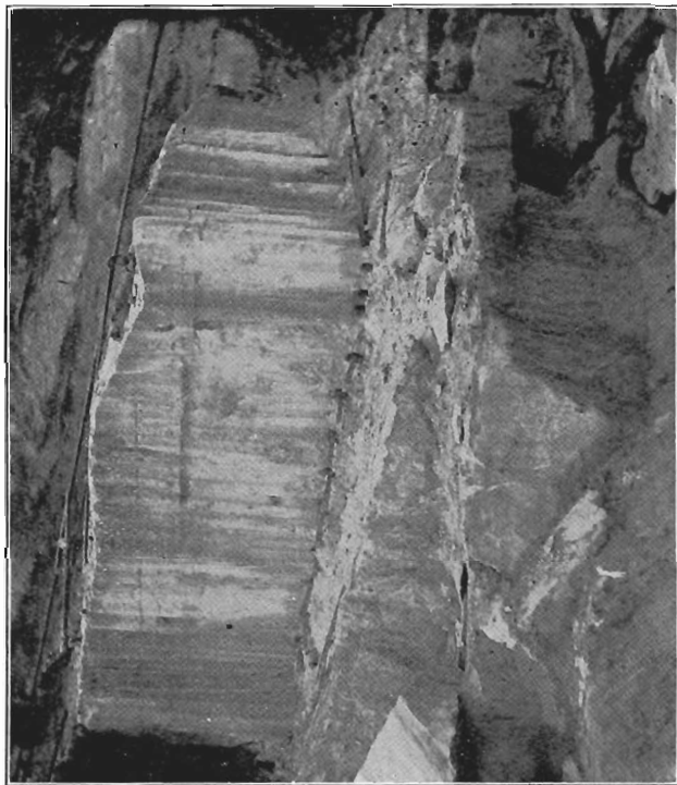
Soulèvement d'un bloc de marbre avec aiguilles et coins.
