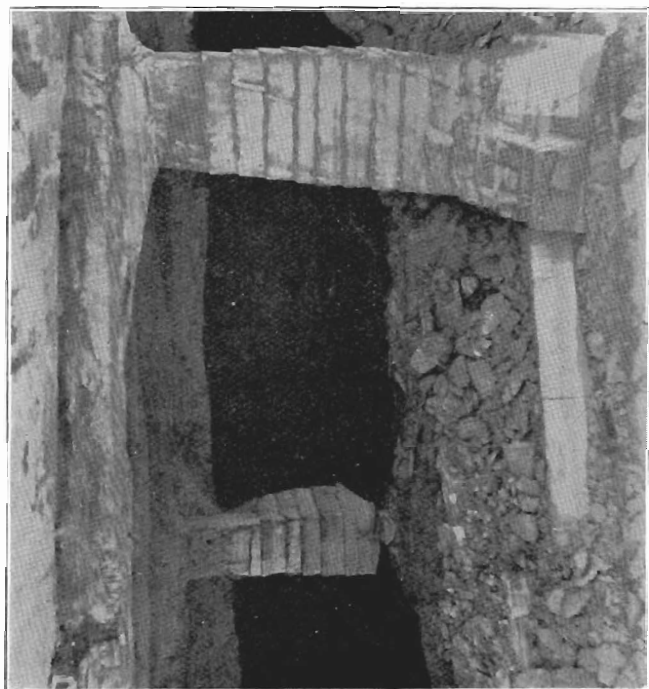
Piliers de marbre supportant le toit dans un tunnel, West Rutland, Vt.
