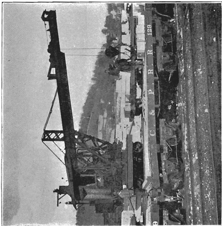
Locomotive grue chargeant des blocs de marbre, West Rutland, Vt.
