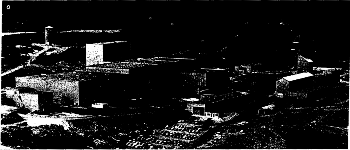
Rio Algom Mines Ltd., Nordic mine, Elliot Lake, Ontario.
