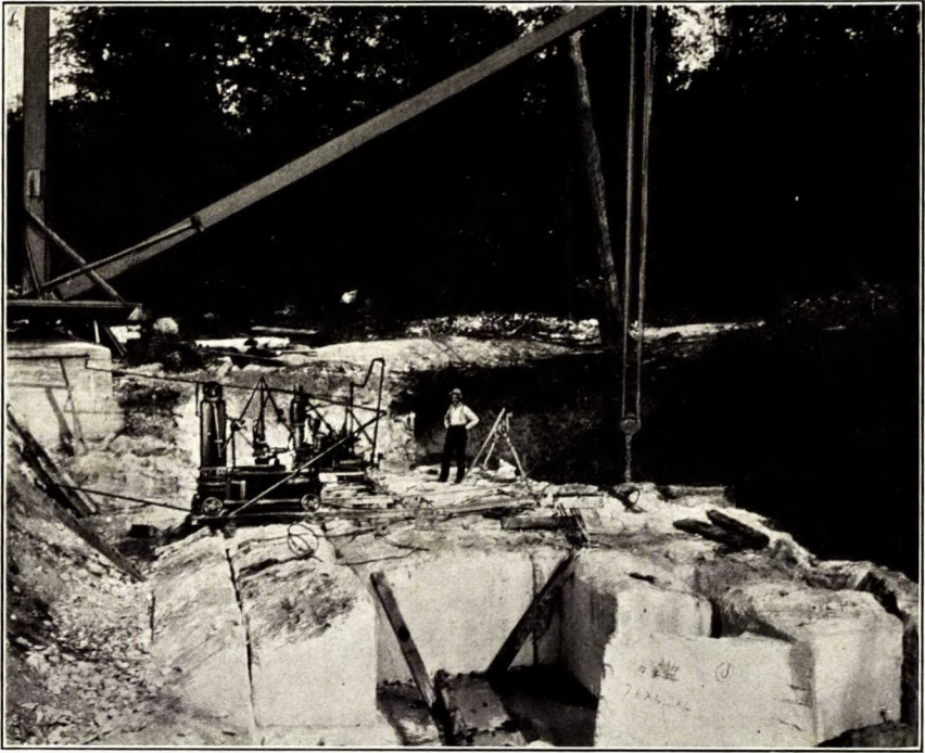
Marbre de Stukely-Sud. Coupe de blocs de marbre de surface à la carrière de la Dominion Marble Co., Stukely-Sud, Qué.
