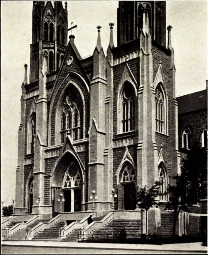
Calcaire Trenton, carrière de Martineau. Église St-Edouard, rue St-Denis, Montréal.
