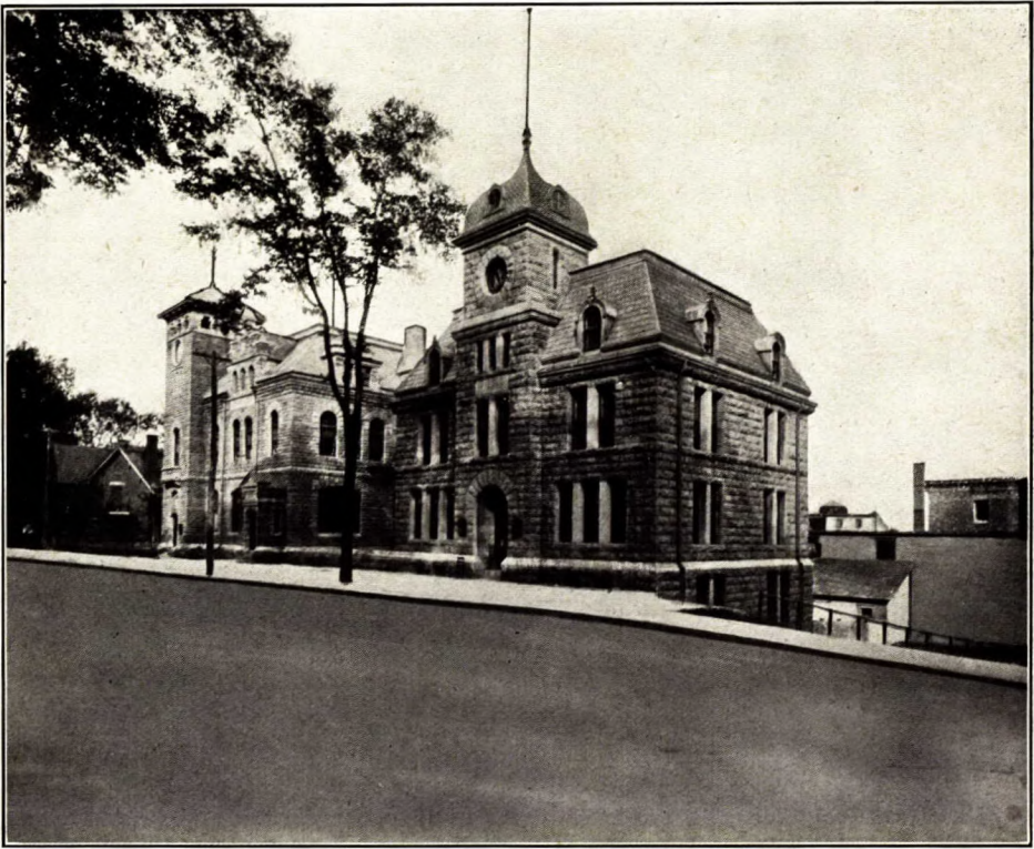
Calcaire de St-Dominique. Edifices municipaux et bureau de poste, St-Hyacinthe, Qué.
