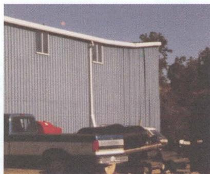
*Exemples de dommages aux bâtiments pouvant être causés par le soulèvement des pieux par le gel.*
