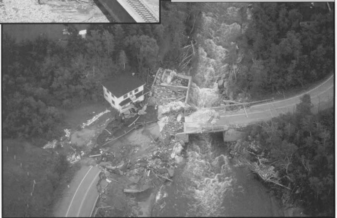
Figure 13. Les chutes à Martel, le long de la rivière du Moulin, présentent un autre exemple de dommages causés à un pont. Ici, les eaux de crue ont débordé au-dessus d'un pont qui crée un engorgement sur un tronçon étroit de la rivière, emportant une partie de la route et endommageant gravement deux maisons construites près de la rivière. Même si le pont a été abîmé, sa structure de base est demeurée intacte. Photographie prise le 27 juillet 1996. (GSC 1997-42WW)
