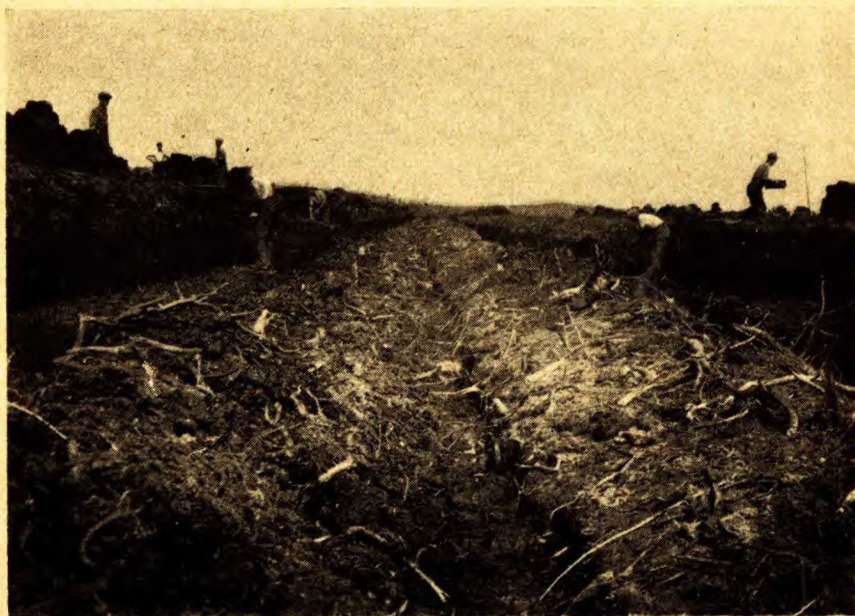
B. Excavating peat moss, Isle aux Coudres, P.Q.
