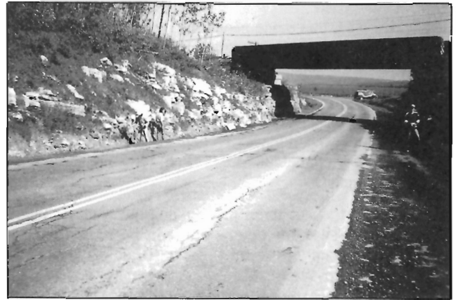
Figure 5. Affleurement de la Formation de Val-Brillant, à l'ouest du village de Val-Brillant (vue vers le nord) : flanc sud-est du synclinal de la Matapédia (fig. 2). Route 132. Le lac Matapédia est visible en arrière du véhicule. GSC 1994-629D.
