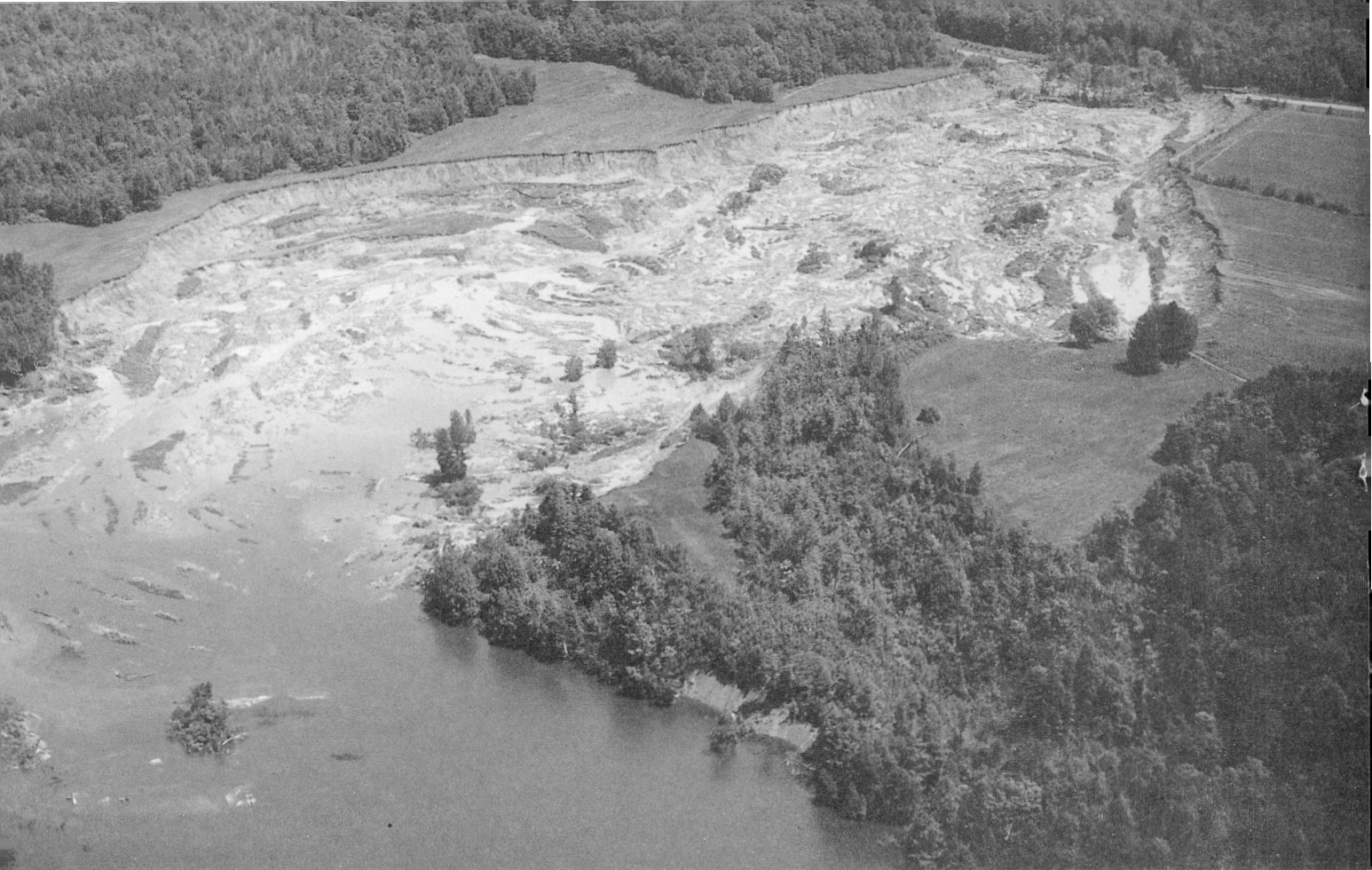
Figure 3. Vue aérienne du glissement de terrain de Lemieux (CGC 1993-254F) prise à la fin de la matinée, le mercredi 23 juin 1993. Le glissement a déplacé entre 2,5 et 3,5 Mm 3 de matériaux dont la majeure partie a coulé dans la vallée de la South Nation, bloquant la rivière (avant-plan). La surface du cratère se trouve jusqu'à 12 m sous le delta d'esker de Russel et Prescott et descend légèrement vers la vallée de la South Nation.
