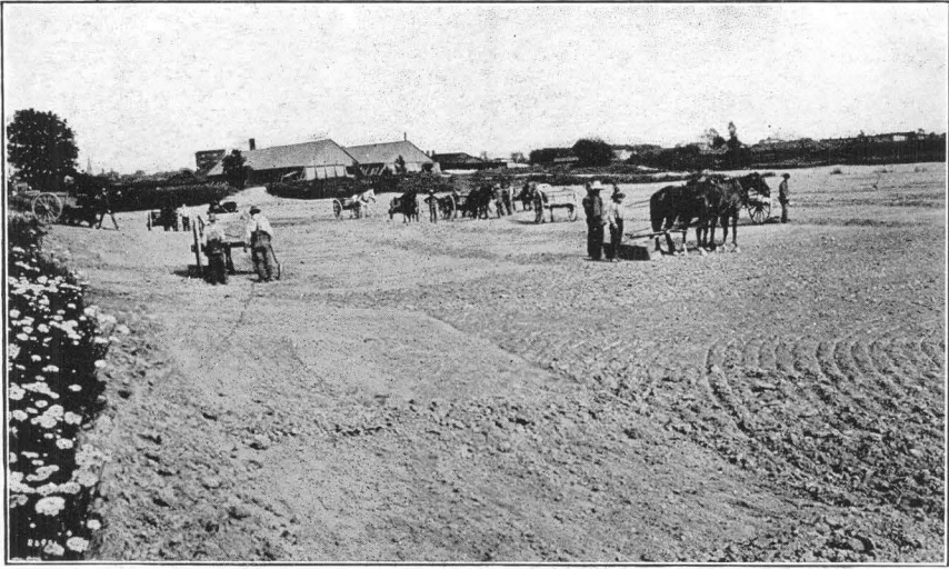
A. Exploitation, par raclage, de la glaisière de la "Standard Clay Products Co." Au dernier plan sont les hangars d'emmagasinage.
