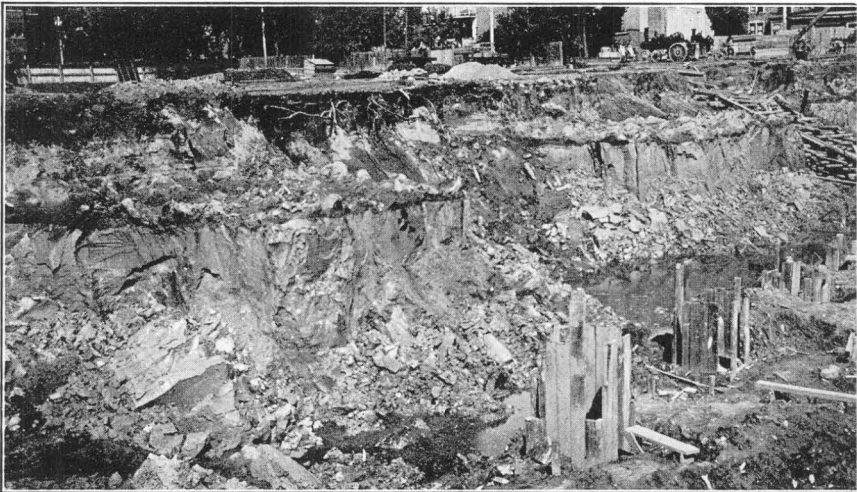
B. Argile Léda recouverte par le sable Saxicava, dans l'excavation des fondations du "High School," Montréal.
