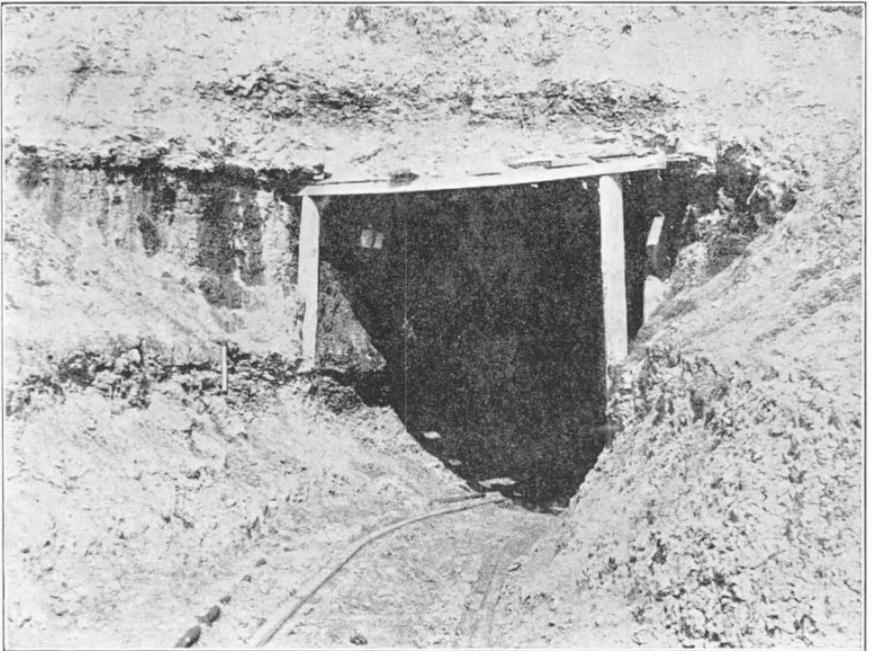
Entrée de la Mine de la Superior Coal Company, côté nord de la rivière Belly, au nord de Taber, Alta. Le marteau marque le bas de la veine de lignite recouverte par le schiste, la voûte est d'argile sableuse.
