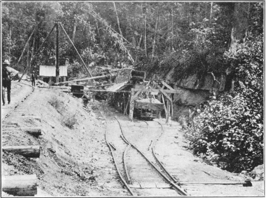
Haut de la voie ferrée de la Clayburn Brick Company, avec entrée de la carrière où elle prend l'argile pour les briques couleur chamois. La coupe montrée dans la planche XXXV est sur le côté gauche de la voie.
