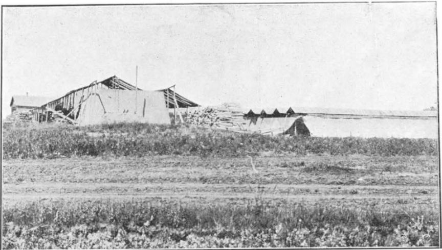
Briqueterie à Saskatoon. Vue montrant les clais de séchage recouvertes d'écrans en toile pour empêcher la dessiccation trop rapide et le craquelage de la brique
