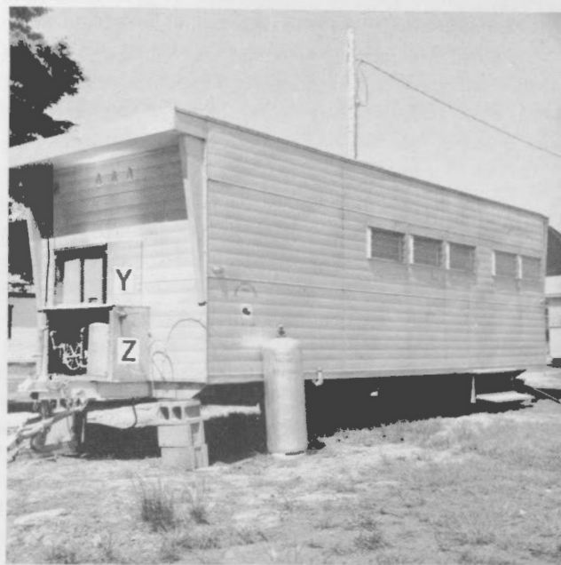
Planche LXVII A. Laboratoire mobile de spectrographie. Y refroidisseur d'eau, Z : pompe à eau.
