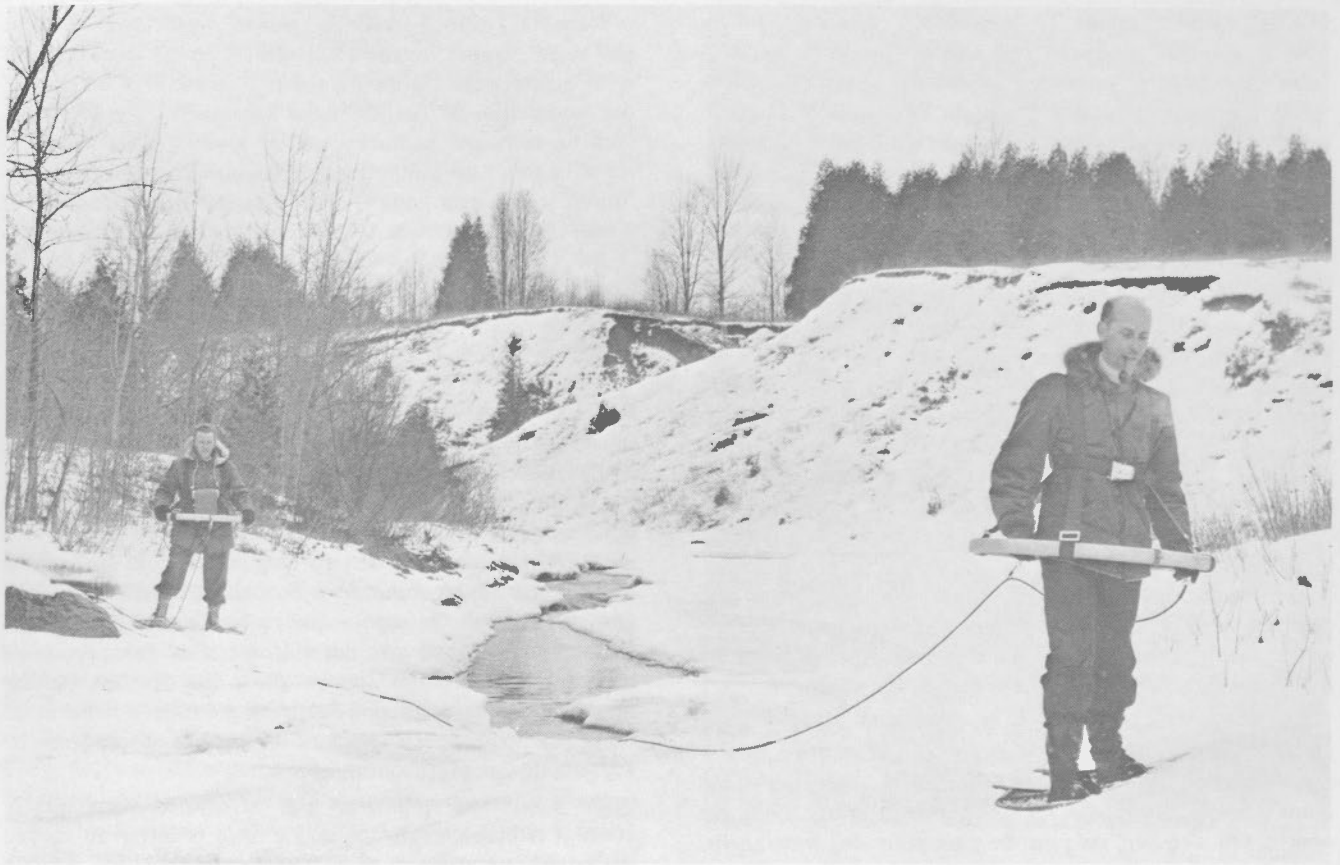
Planche LXIV Emploi de la méthode électromagnétique (photo de la Lockwood Survey Corporation Limited).
